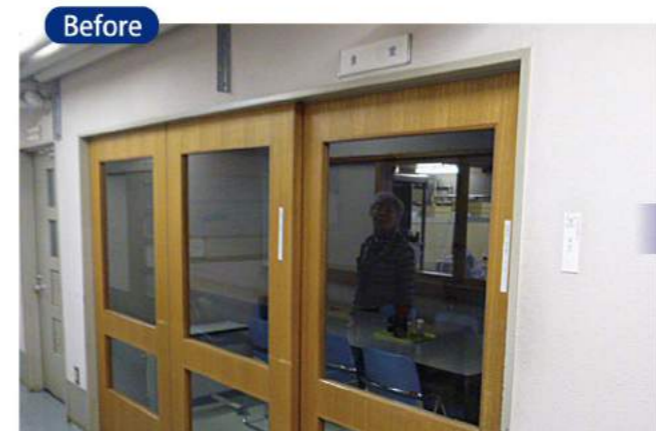
廊下側のガラス戸
